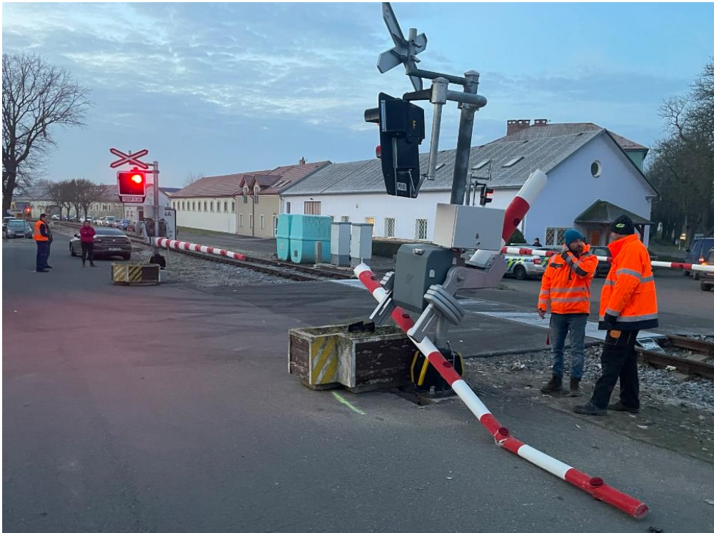
Snímek poškození závorového stojanu při dopravní nehodě
