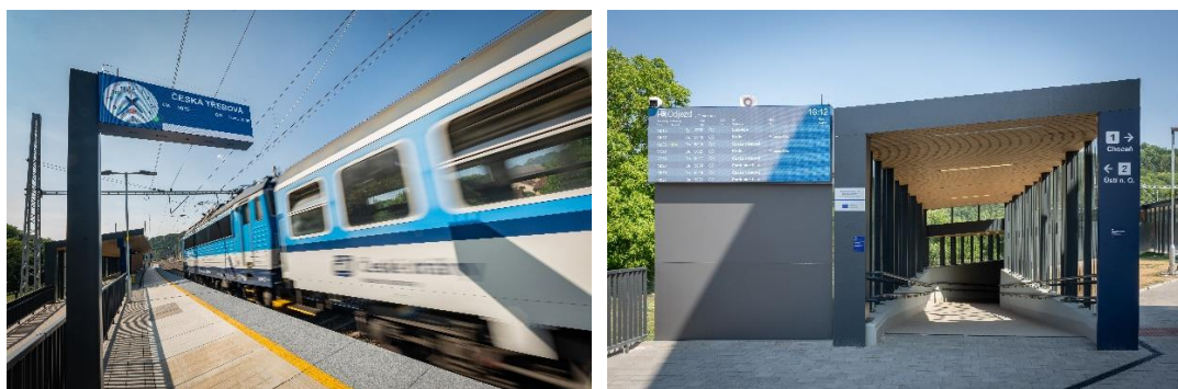
Obr. č. 7 - Tabule STARLIT – instalace žst. Brandýs nad Orlicí.
