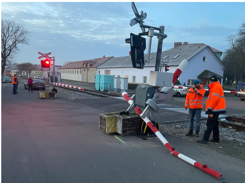
Snímek poškození závorového stojanu při dopravní nehodě
